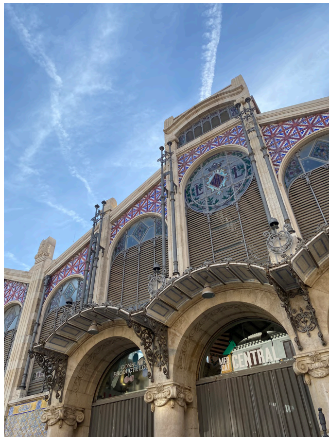
Figure 14. Photographie de la façade du Mercado Central.
