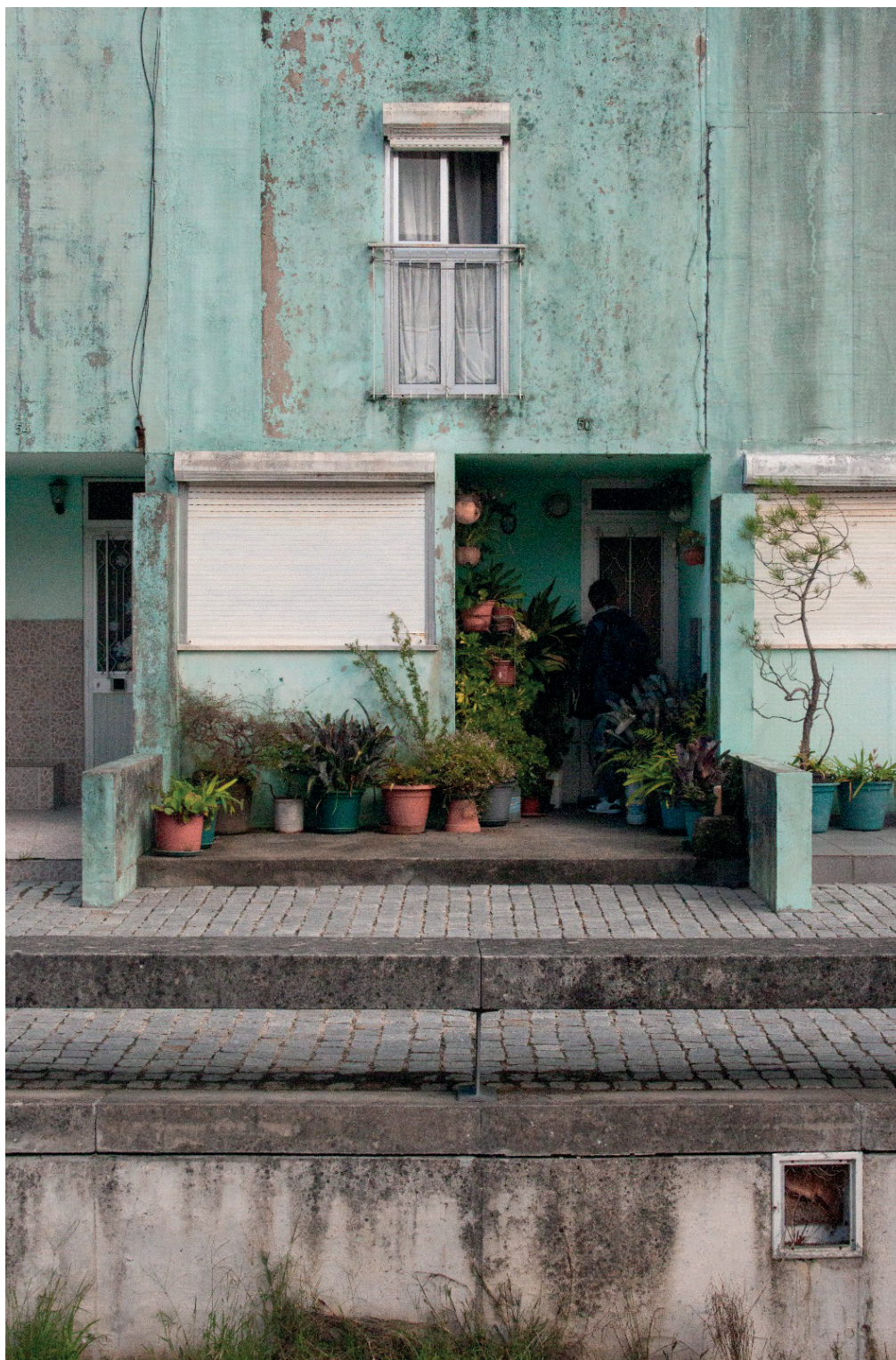
Photo prise par un ami, Giulio Schiavon, de SAAL São Victor, projet de logement sociaux d'Álvaro Siza, construit entre 1974 et 1977.
