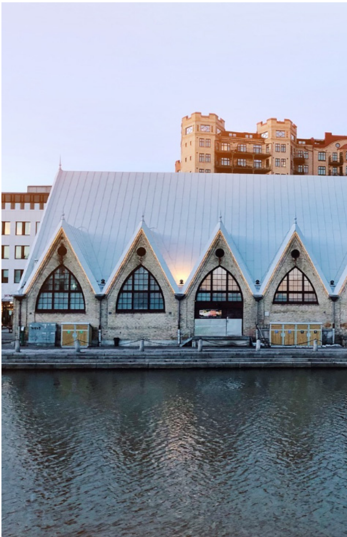
Feskekorka - Ancienne église transformée en halle aux poissons
