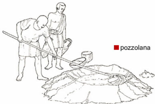
*4 : Création du pozzolana ( béton )
