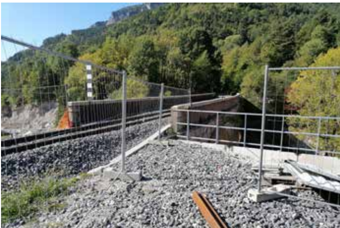
Saint-Dalmas de Tende : pendant la crise une gare provisoire a été installée au croisement de la route départementale et de la ligne de train.
