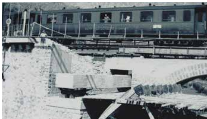
1930 - Passage d'un train international avec un wagon Bern - Lotschberg - Simplon pendant les travaux de renforcement du pont de la Lavina. Source : collection J.L. Taylor
