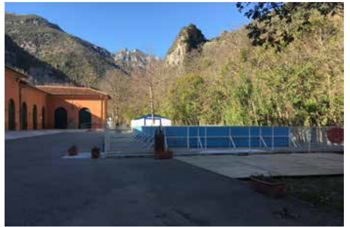
La gare de Fontan-Saorge : ancienne colonie de vacances. Pendant la crise, le parvis a été occupé par les camions des travailleurs 2022.
