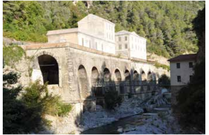
Le bâtiment de la gare de Piene Basse en 2021, après une mise en sécurité. Source : Etienne Markt
