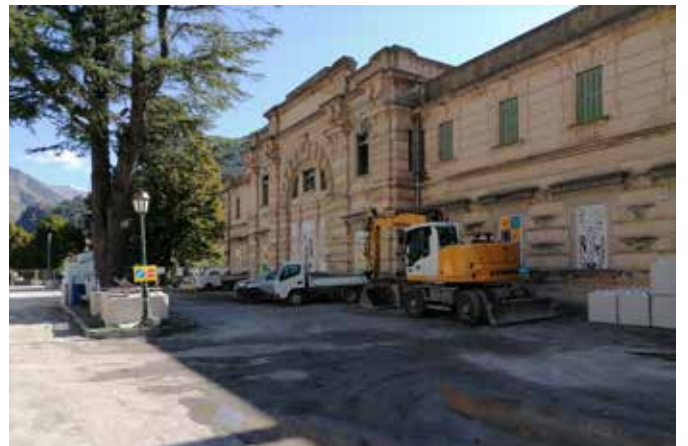
Le parvis de la gare de Saint-Dalmas de Tende utilisé pour garer les engins et stocker les matériaux des chantiers de la reconstruction. 2022.
