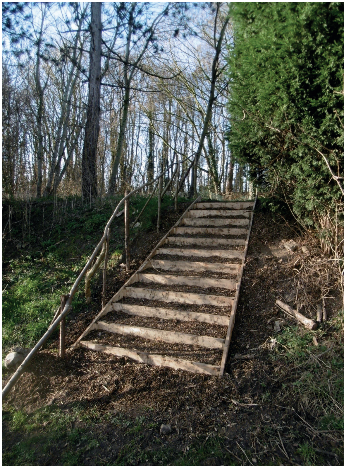
Fig. 3 — Construction d'un escalier d'accès à un talus autoroutier. Collectif Likoto, Février 2022
