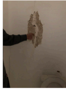
Fissure, rebouchée sous peinture, mur au R+1
