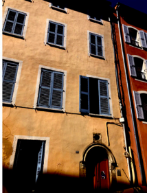
Le 34 depuis la Rue de l'Observance
