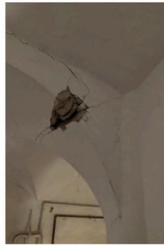
Sondage arcs de l'escalier
