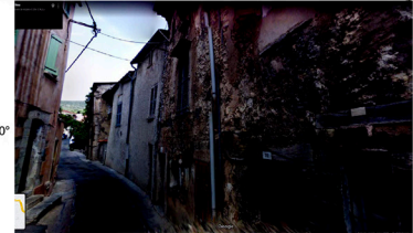
Rue Courtilou (façade Ouest du 34) avant
