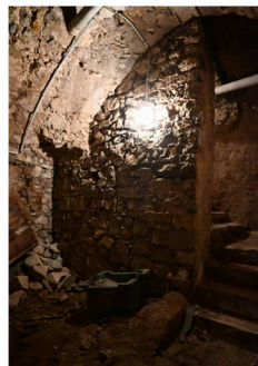
Paillasser escalier intégré à la voûte de la cave
