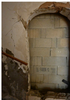
Partie d'immeuble murée (pour démolition)
