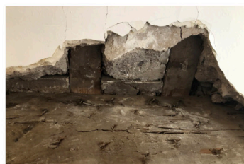
Chevrons sur poutre porteuse, plafond R+1 de la cuisine
