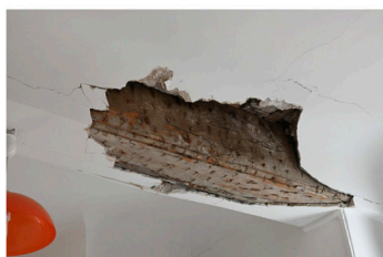
Poutre porteuse «bôchers», plafond R+1 de la cuisine
