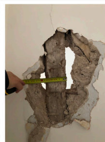
Sondage mur fin, couloir du logement au R+1
