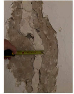
Fissure, rebouchée sous peinture, mur au R+1
