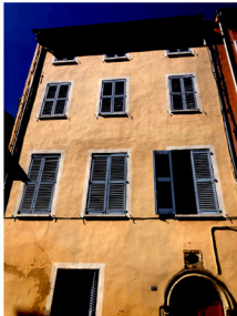
Le 34 depuis la Rue de l'Observance
