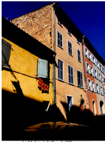
Le 34 depuis la Rue de l'Observance
