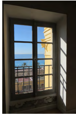
Figure n°11 – Vue de la fenêtre située au-dessus de l'entrée de la chapelle de la Miséricorde. (photographie de l'auteur)
