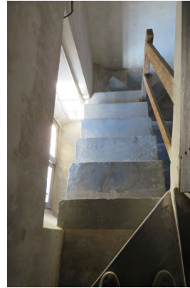
Figure n°15 Escalier secret de la chapelle de la Miséricorde. (photographie de l'auteur)
